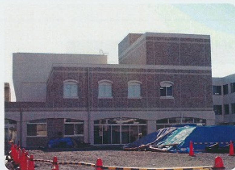
工事中の厨房棟
